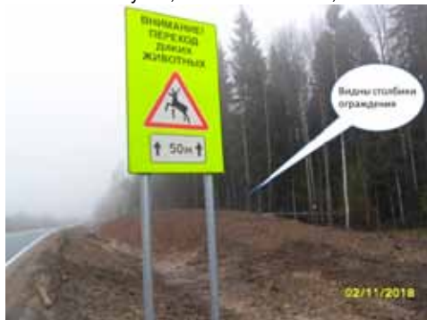
Ошибочно установленное ограждение на планируемом переходе. Фото Смирнова А.С.
