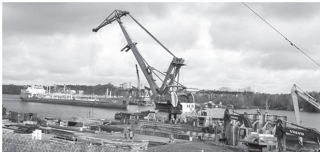
Стройплощадка будущей базы развернута широко.
